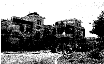
Строительство детского сада по ул. Почтовой в г. Геленджике на 120 мест
