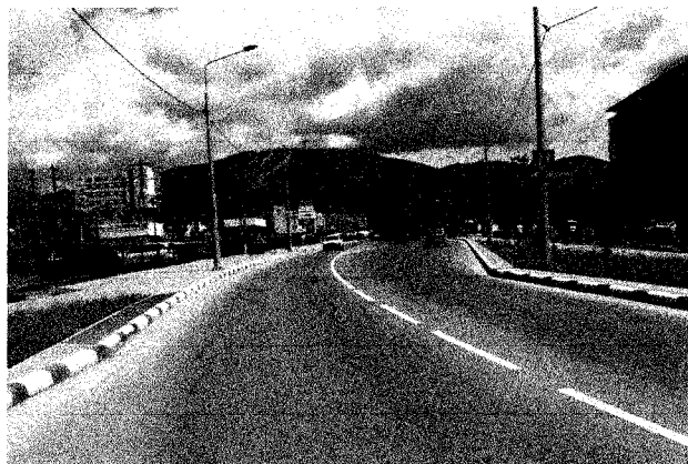
Реконструкция дорожного покрытия
